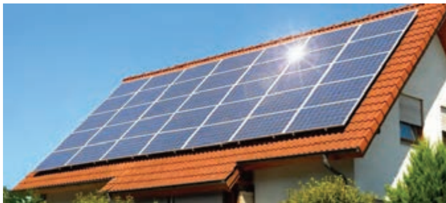
تصویر ۷ - نمونه ای از نصب آرایه های فتوولتائیک بر روی سطح بام شیب دار
